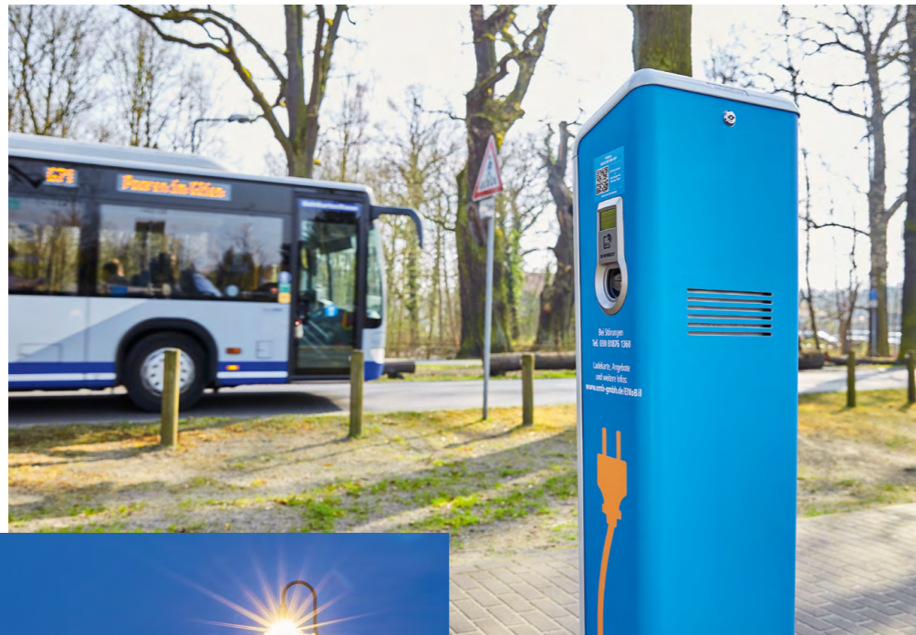
In Schönwalde-Glien haben EMB und Kommune Ende 2017 eine Elektro-Ladesäule in Betrieb genommen.
