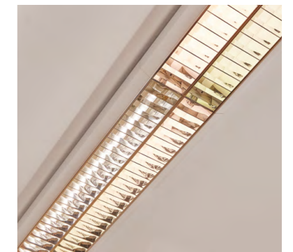
Auch im Rathaus sind die Leuchten teilweise ausgetauscht worden. Die neuen Lampen (links unten) erzeugen ein natürlicheres Licht und benötigen weniger Energie.
