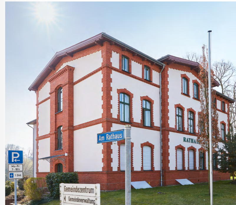
Verwalten im Altbau: das Rathaus der Gemeinde Großbeeren
